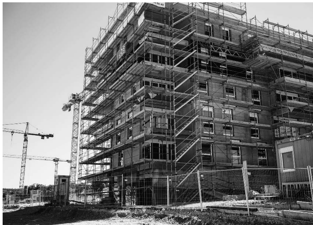
Les 42 arcades des Vergers devront concilier viabilité financière avec engagement écologique et social.
